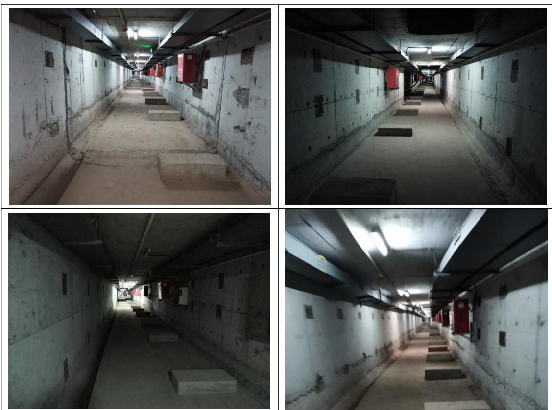
管廊仓体内排水设施调查
