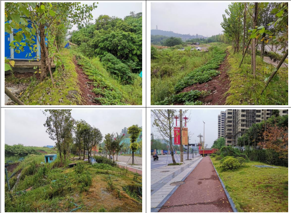
管廊段地表植被调查-石羊大道 B 线
